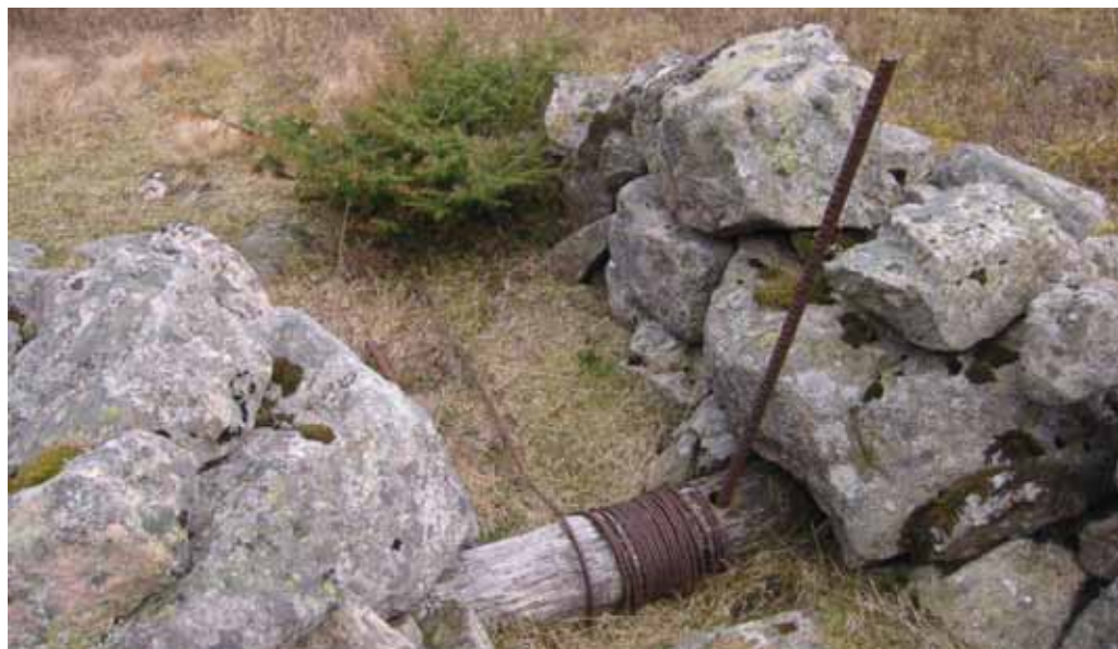
Tydelige detaljer i mottaks-/strammepunktet i innmarka på Eikeskog.
