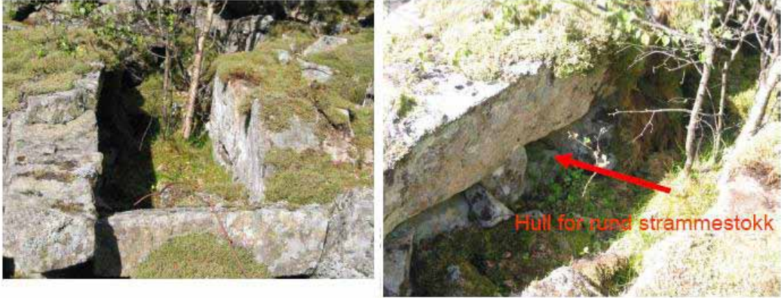
Fig. 4. Øverst: Mottaksanlegg med strammefeste ved trasépunkt nr. 4. Legg merke til restene av løypestreng til venstre. Til høyre ser vi også hull for rund strammestokk. Under: Prinsippskisse av løypestreng. Oppe til venstre er vist et sendepunkt sett fra siden. Oppe til høyre er vist et mottakspunkt sett i fugleperspektiv mens det under til høyre er sett fra siden.
