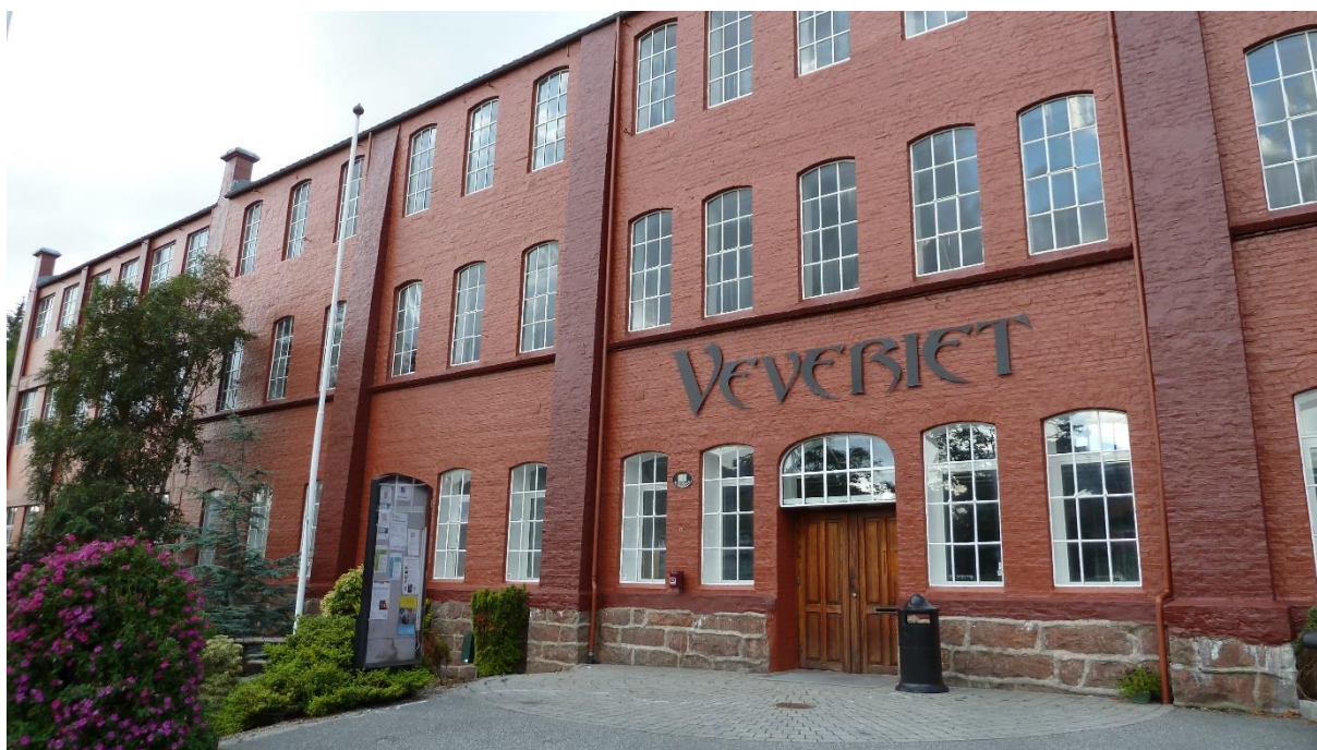
Veveriet etter fasaderehabiliteringen i 2015. Bilde: ØT
