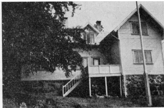
FOLKEKJØKKEN, gnr. 7, bnr. 11. Postadr. Ålgård. Areal 0,5 da. Hovedbygn. oppf. 1892 av bindv. i 1½ etsj., 125 m 2 , i 1. etsj. 3 spisesaler, kjøk., i 2. etsj., 4 rom, bad. Til nåv. eier 1892. — Eier De Forenede Ullvarefabriker, D. F. U., A/S.
