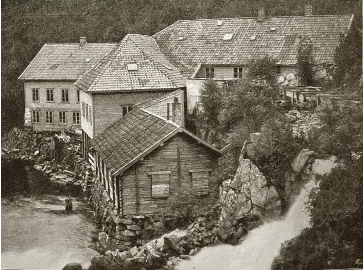
Det første fabrikkanlegget ved Ålgårdsfossen rundt 1880. Det nærmeste bygget er en tidlig utgave av Stamphuset. Mellom Stamphuset og fabrikkbygningen skimter vi et tilbygg med skråtak. Sannsynligvis var vannhjulet montert her, drevet av vann fra tilførselskanalen vi skimter til høyre. Det lille fossefallet til høyre er ikke selve Ålgårdsfossen, men overskuddsvann fra tilførselskanalen. Bilde: Ålgård Rotarys bildearkiv
