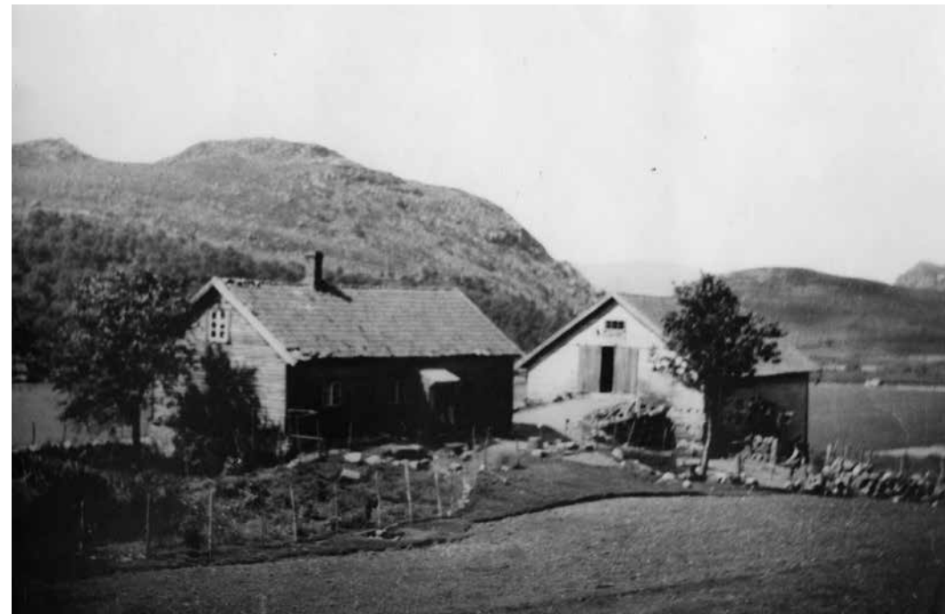
Dette er der nord på Auestad i 1930 åra. Det er same hovudbygning som på bilete frå 1905. Uthuset på dette bilete er oppført i 1913. Stener hadde fotoapparat, eg fekk låna det ein søndag og gjekk over Vindheia og kom ned bak husa og tok bilete. Stener kalla det fram(som me sa) Eg fekk det forstørta, nei trur mest Stener gjorde det og sjølv. Han kunne mykje. Utan Stener og at eg kom til Hadland, hadde me ikkje hatt dette. Bilete er teke etter at Ola hadde begynt å stella hagen.
